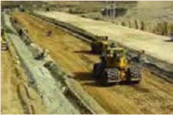
مراحل ساخت سد خاکی
